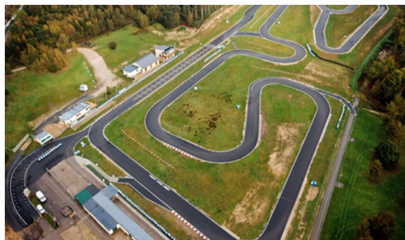
Le circuit d'Anneville (76) récemment rénové et ses 1217m de long. © Photo www.karting-normandie.fr
